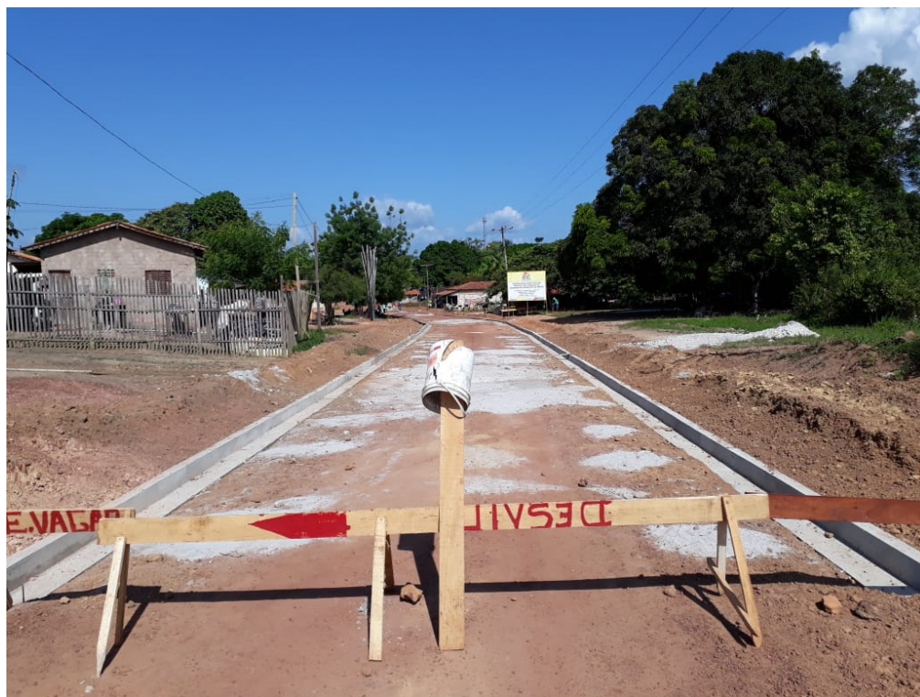
MEIO FIO E LINHA D'ÁGUA
