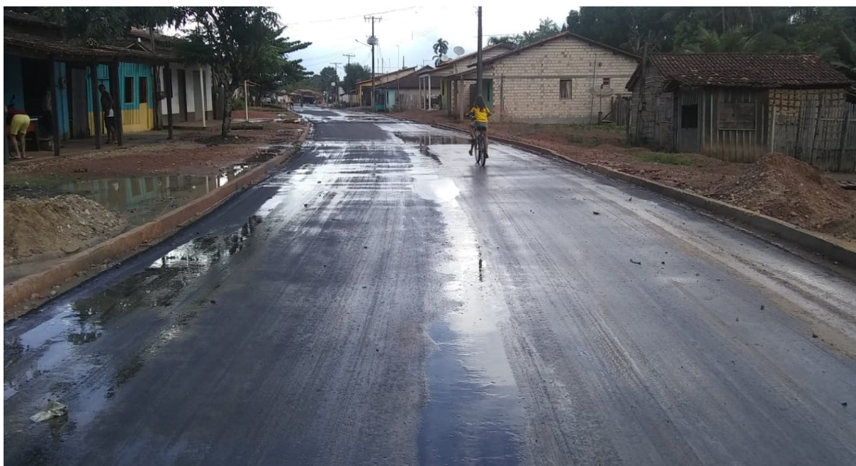
PAVIMENTAÇÃO ASFÁLTICA - FOTO 05/01/2020
