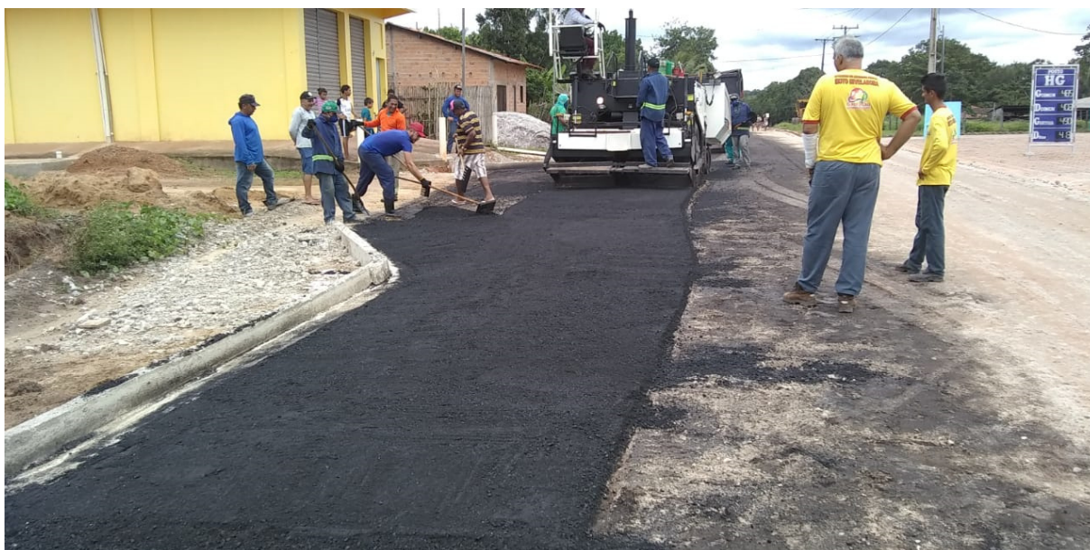
PAVIMENTAÇÃO ASFÁLTICA - FOTO 30/12/2019
