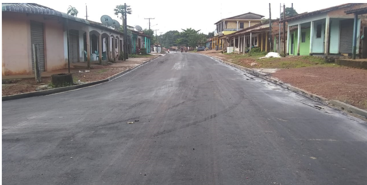
PAVIMENTAÇÃO ASFÁLTICA - FOTO 05/01/2020
