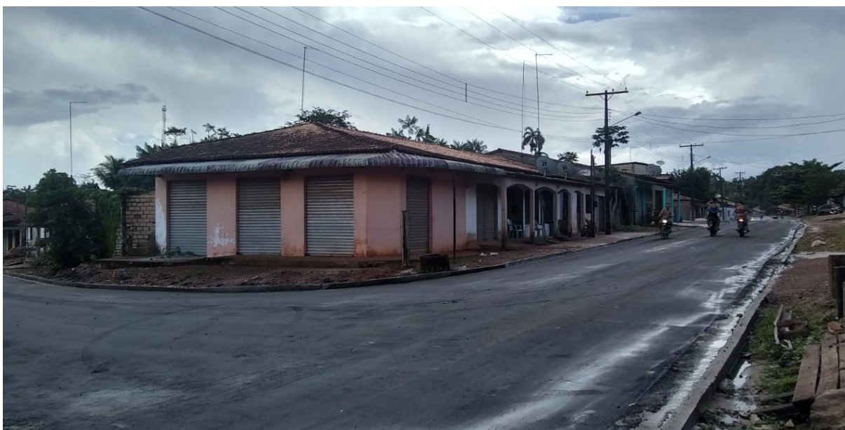
PAVIMENTAÇÃO ASFÁLTICA - FOTO 10/01/2020
