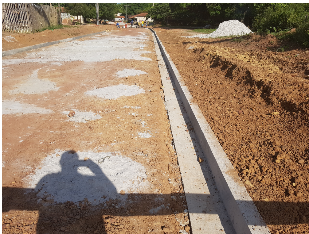
MEIO FIO E LINHA D'ÁGUA
