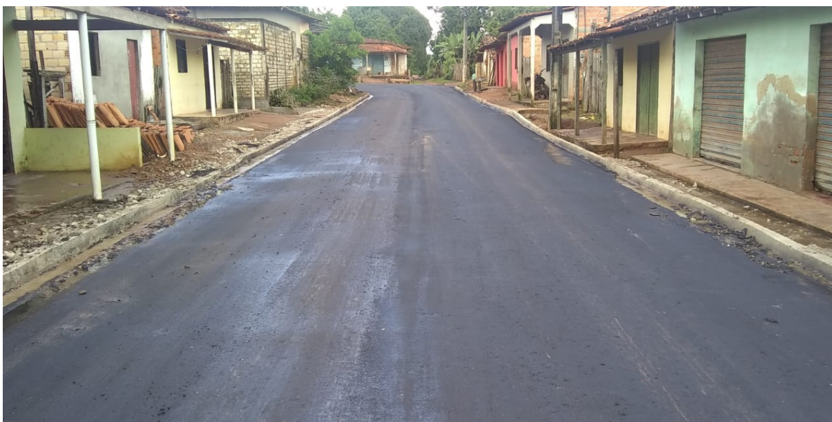
PAVIMENTAÇÃO ASFÁLTICA - FOTO 10/01/2020
