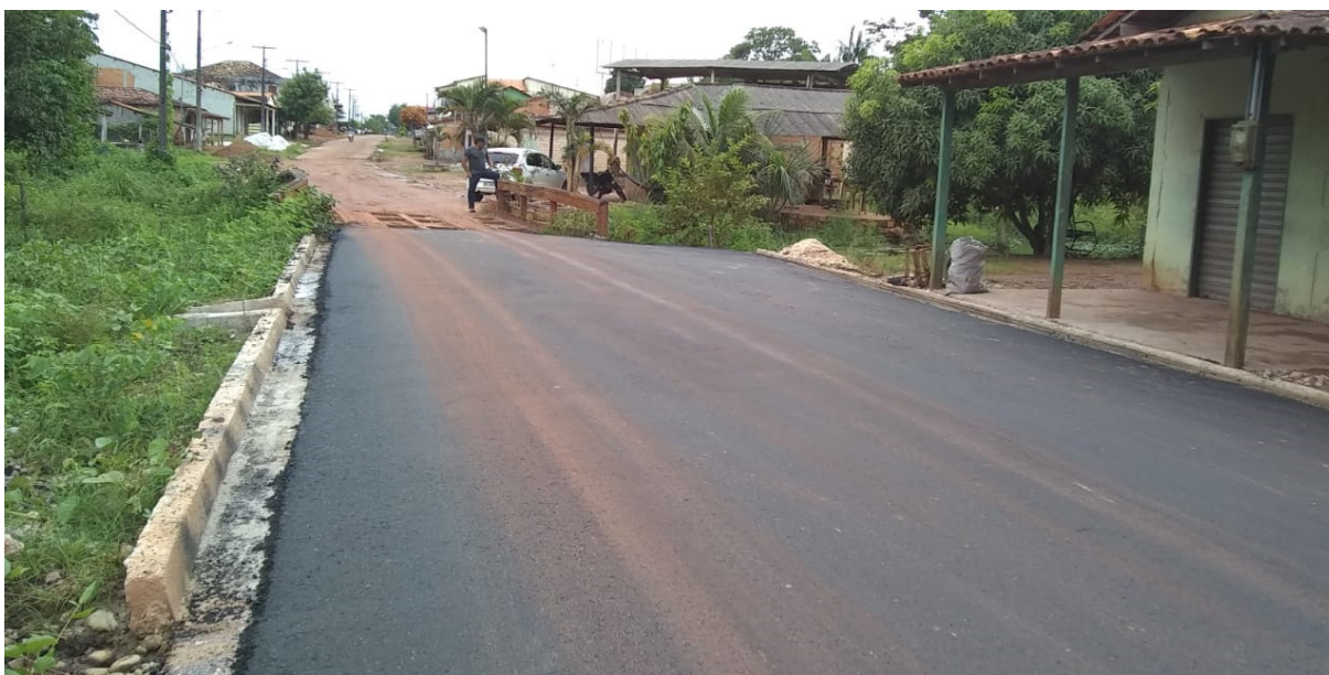
PAVIMENTAÇÃO ASFÁLTICA - FOTO 15/01/2020
