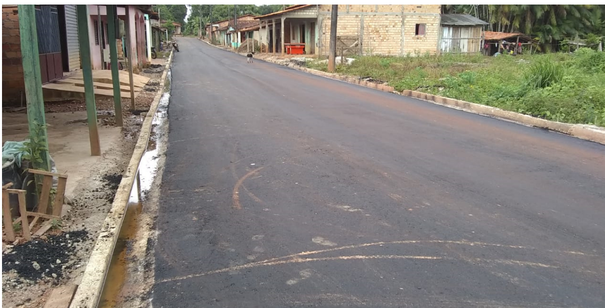
PAVIMENTAÇÃO ASFÁLTICA - FOTO 15/01/2020
