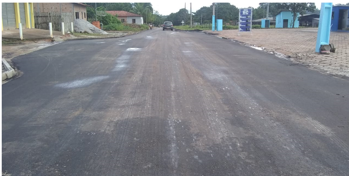
PAVIMENTAÇÃO ASFÁLTICA - FOTO 31/12/2019
