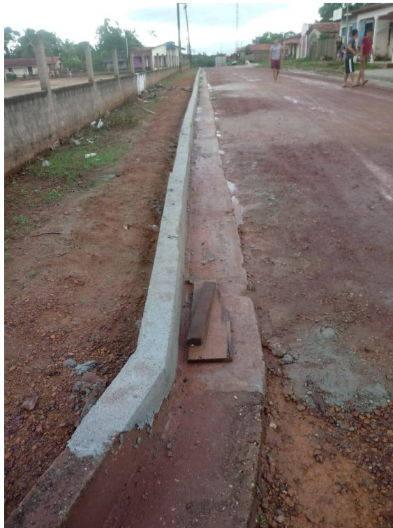
MEIO FIO E LINHA D'ÁGUA – FOTO 26/12/19
