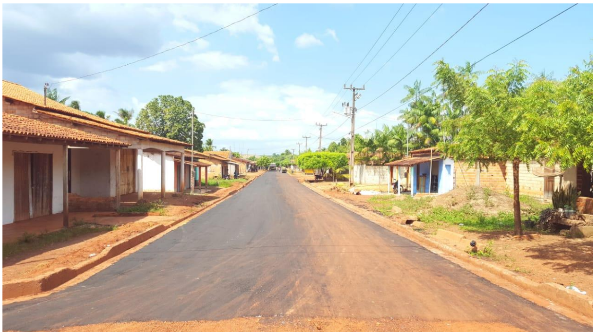
PAVIMENTAÇÃO ASFÁLTICA – FOTO 26/12/19
