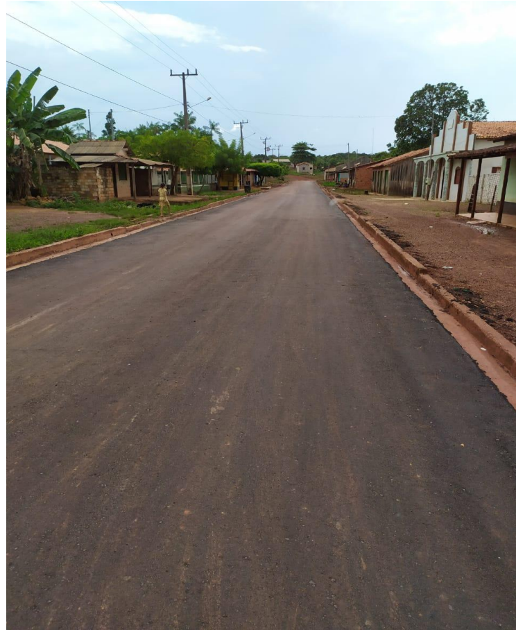
PAVIMENTAÇÃO ASFÁLTICA – FOTO 26/12/19
