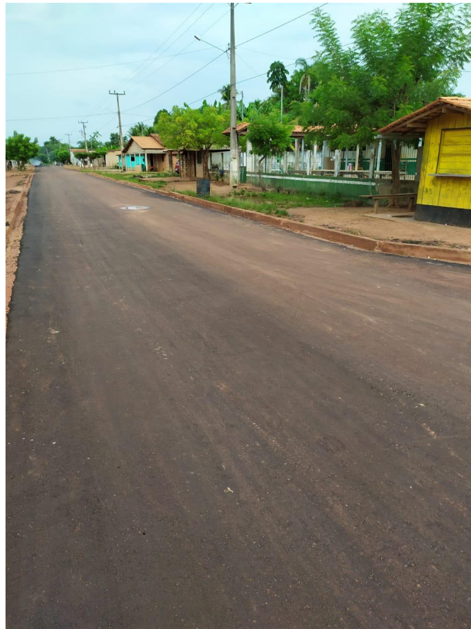
PAVIMENTAÇÃO ASFÁLTICA – FOTO 26/12/19
