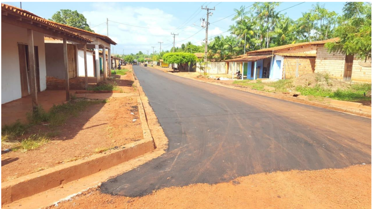
PAVIMENTAÇÃO ASFÁLTICA – FOTO 26/12/19
