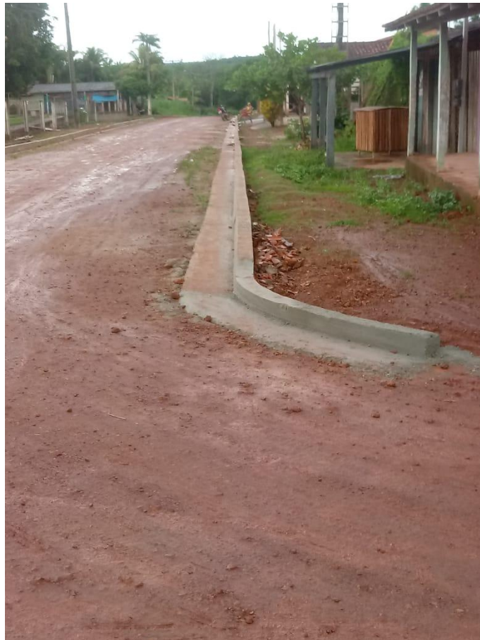
MEIO FIO E LINHA D'ÁGUA – FOTO 26/12/19
