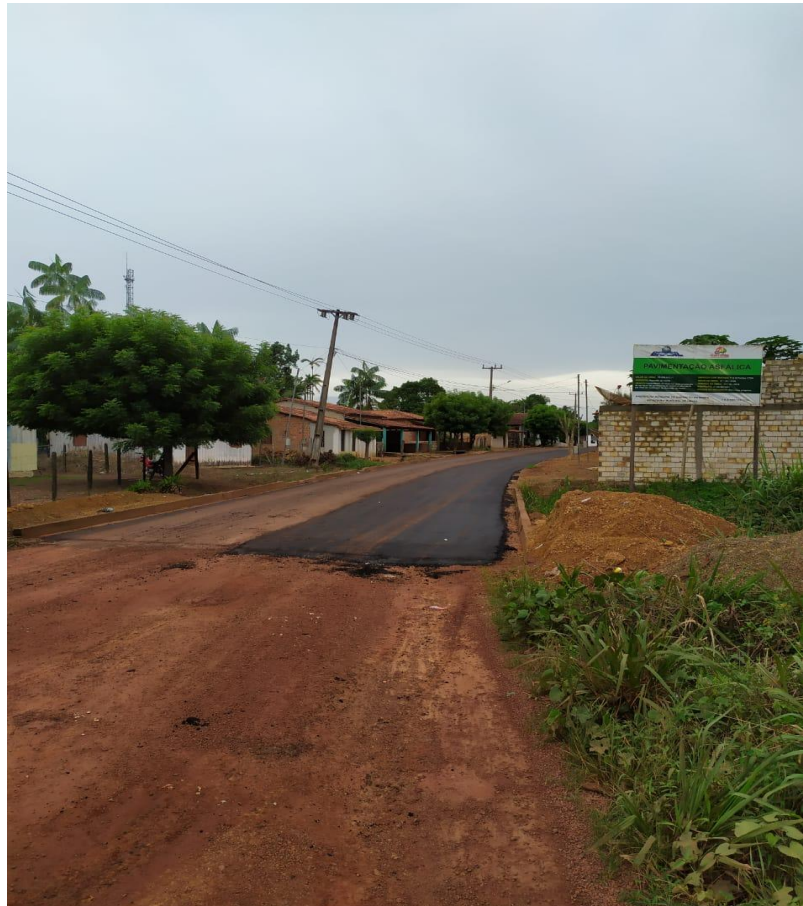
PAVIMENTAÇÃO ASFÁLTICA – FOTO 26/12/19
