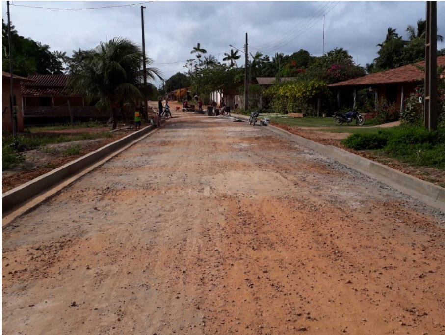
MEIO FIO E LINHA D'ÁGUA – FOTO 26/12/19
