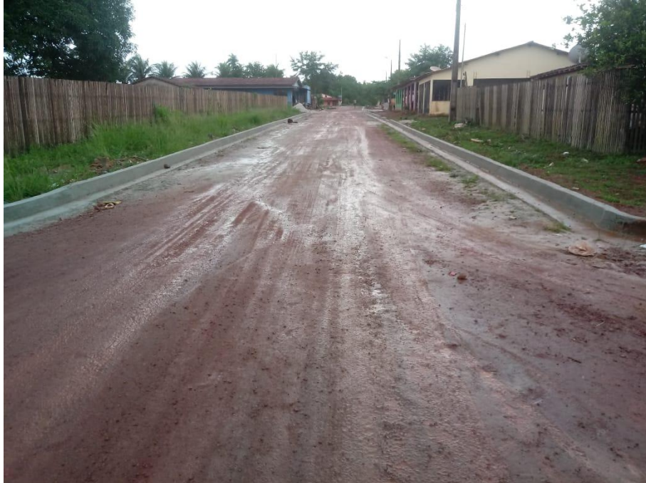
MEIO FIO E LINHA D'ÁGUA – FOTO 26/12/19
