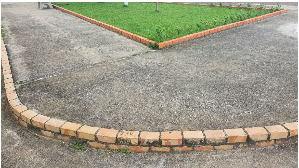
PINTURA DO PISO
