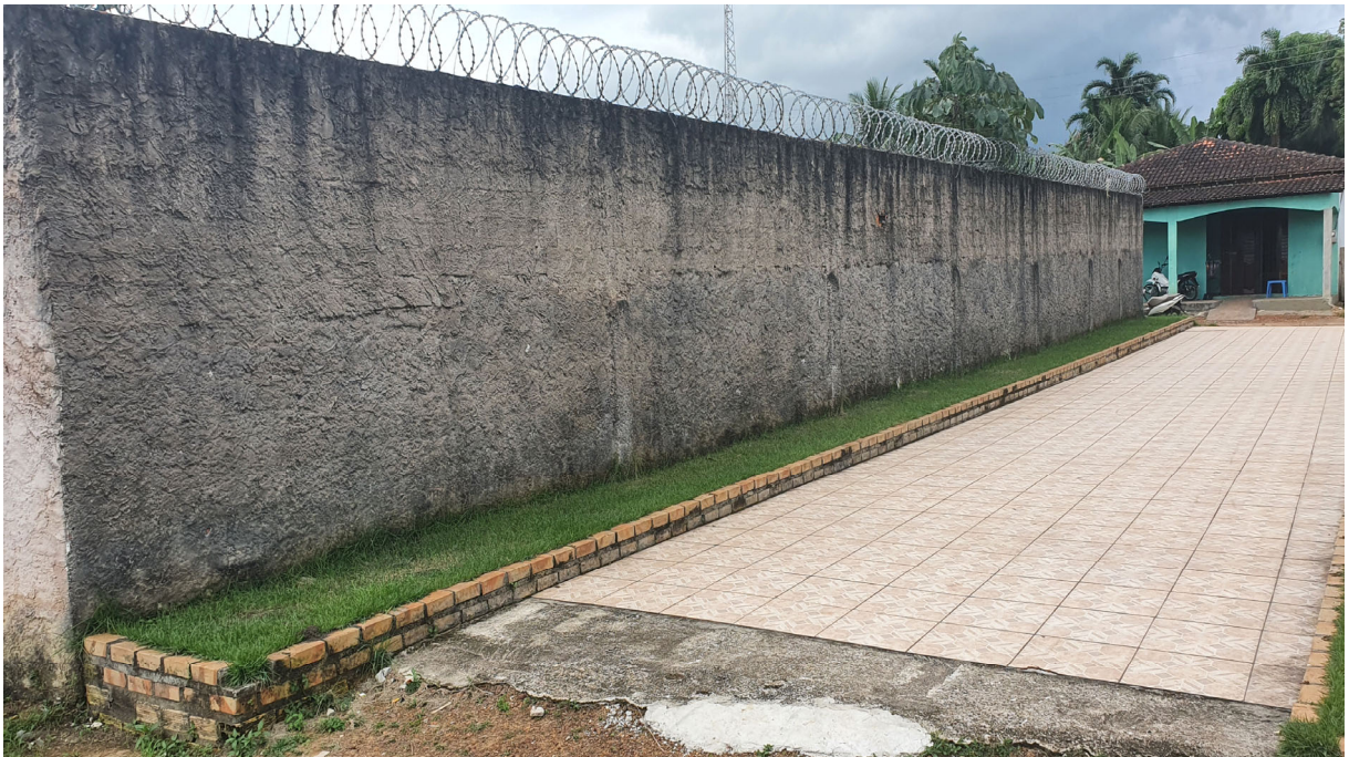
PAREDE A SER REBOCADA
