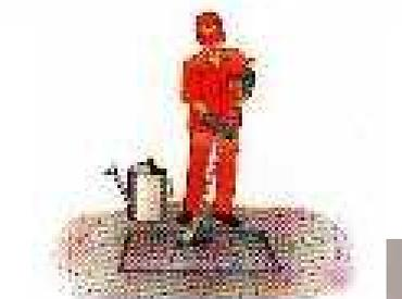
5- Executar a pintura de ligação no fundo e nas paredes verticais da área recortada, utilizando emulsão asfáltica tipo RR –1C, pura, ou diluída no máximo com 20% (vinte por cento) de água, a critério da fiscalização. A emulsão deve cobrir toda a área que vai receber a massa asfáltica, sem se acumular em poças. Deve-se estender a pintura de ligação por 10 a 20 cm sobre o pavimento existente, isto é, para cada lado do buraco.
