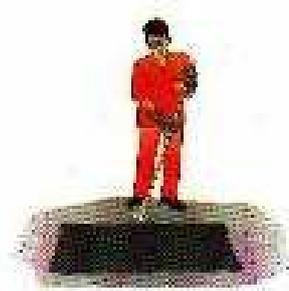
12- Retirar com uma varrição os materiais granulados excedentes que normalmente ficam nas junções da massa nova com o pavimento velho. Deixar o local da operação bem varrido. Os materiais excedentes devem ser depositados junto com os resíduos e entulho referidos na atividade 3, desta sequência.
