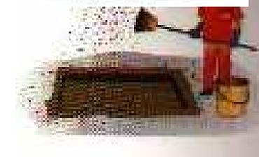
6- Preencher o local com CBUQ Faixa C, na temperatura entre 110°C e 177°C, ou PMF de graduação densa na temperatura ambiente. O preenchimento deve ser cuidadoso e ser iniciado 5 (cinco) minutos após a execução da pintura de ligação, devido à necessidade de ruptura da emulsão asfáltica. Com a utilização de rastelo a massa deve ser bem espalhada, preenchendo todo o espaço formado pelo recorte, nivelando a massa com o pavimento existente.
