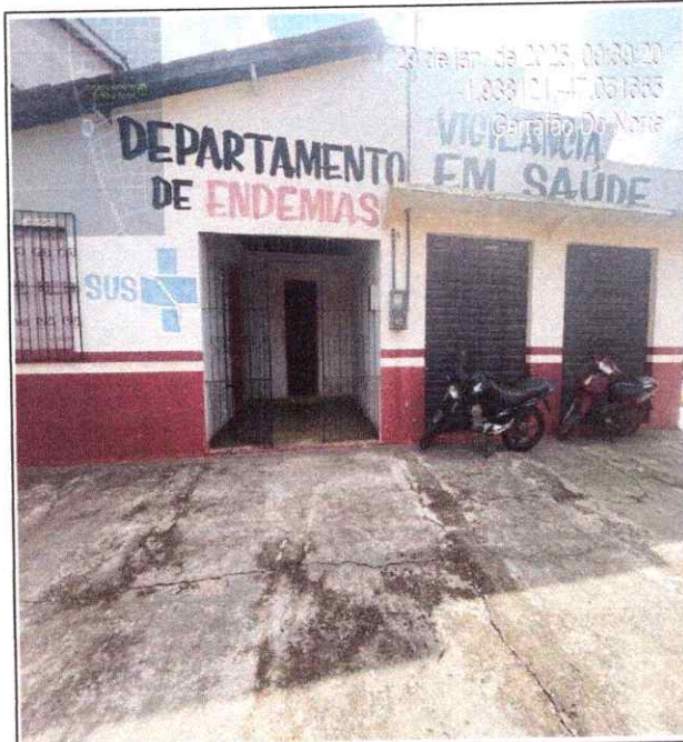
VISTA FRONTAL DO IMÓVEL
