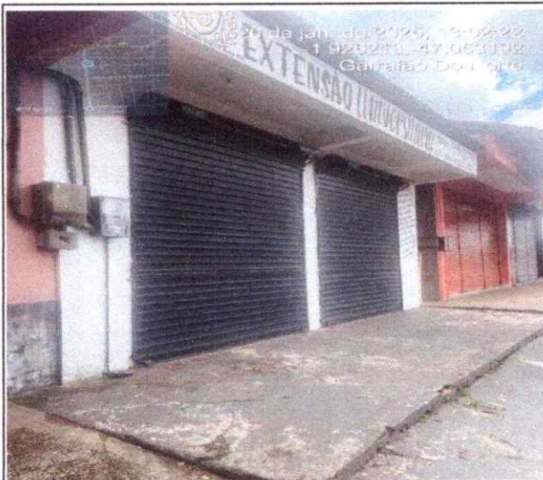
VISTA LATERAL DO IMÓVEL
