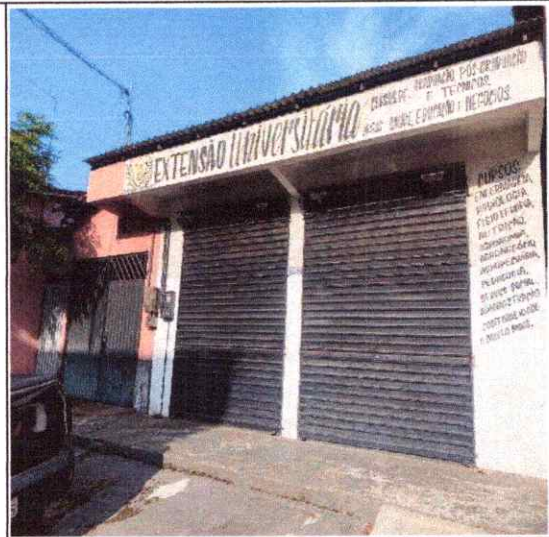
VISTA FRONTAL DO IMÓVEL
