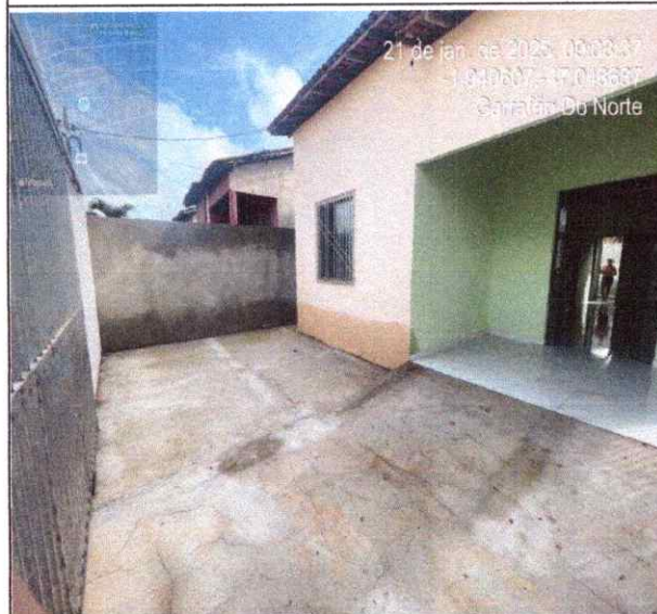
VISTA FRONTAL INTERNA
