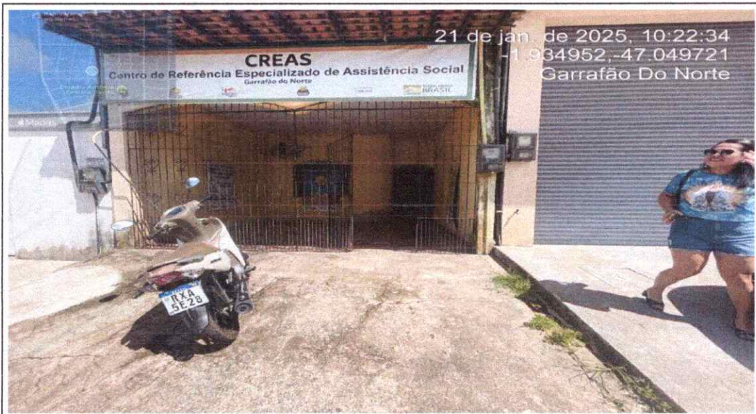
VISTA FRONTAL DO IMÓVEL
